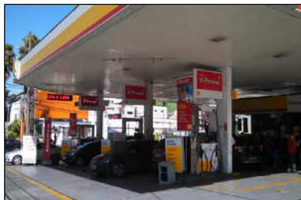
Figura 3.5 - Parte interna e altura da cobertura. Fonte: Próprio autor
